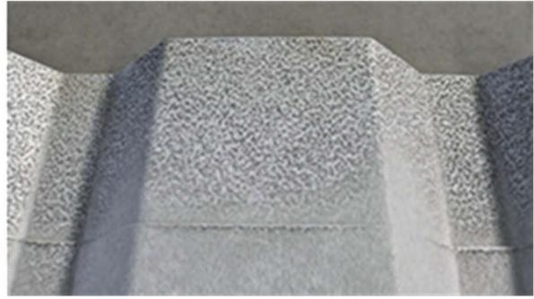
Montieren Sie die Trapezplatten einzeln, diese müssen 40mm (4cm) in die Rinne ragen. Falls notwendig, müssen die Platten zugeschnitten werden. Der Zuschnitt erfolgt auf der Firstseite.
